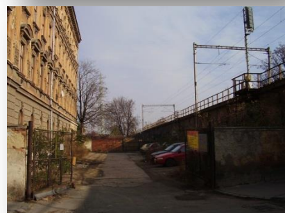
Obrázek 22: Městské viadukty znehodnocují okolní zástavbu měst (Brno, Vlhká ulice)
