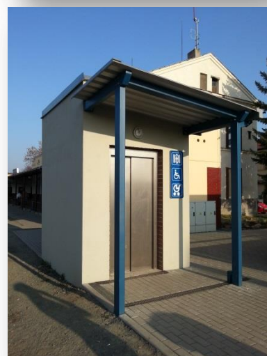
Obrázek 14: Jednoduchá zastávka příměstské železniční dopravy s přístřeškem, podchodem a bezbariérovým přístupem (Horní Počernice, realizace 2012)
