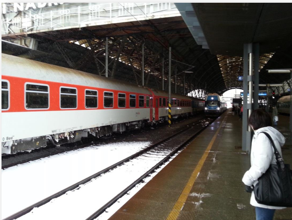
Obrázek 34: Souběh provozu mezinárodní, meziměstské a příměstské železniční dopravy na Hlavním nádraží v Praze
