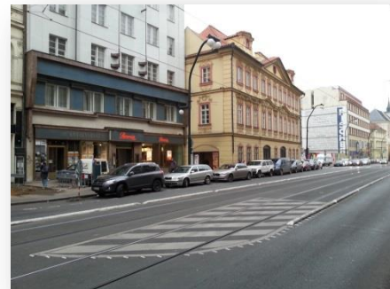
Obrázek 3: Tramvajové těleso s živým povrchem
