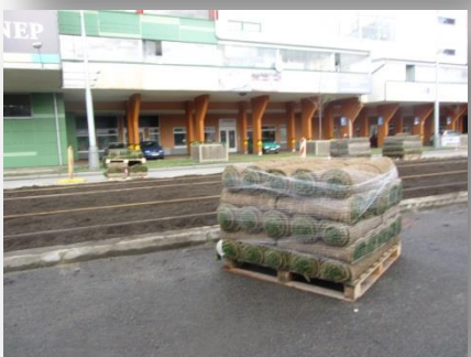
Obrázek 8: Tramvajové těleso s travnatým povrchem a pokládka travnatého pásu
