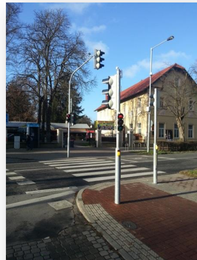
Obrázek 10: Přechod se světelným signalizačním zařízením (Praha Klánovice)
