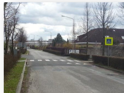
Obrázek 4: Zvýšená úroveň vjezdu do obytné zóny (zde ochrana přechodu a zpomalení vozidel na vjezdu do obce, Zeleneč)
