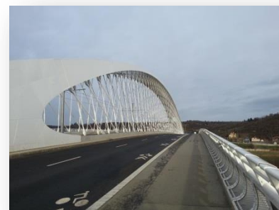
Obrázek 12: Pěší lávka jako součást základní mostovky Trojského mostu v Praze (zavěšená konstrukce mostu)
