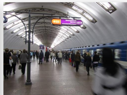
Obrázek 25: Příklad jednolodní ražené stanice Sadovaya v Petrohradě
