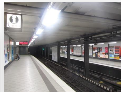
Obrázek 13: Hloubené úseky metra v německém Hamburku
