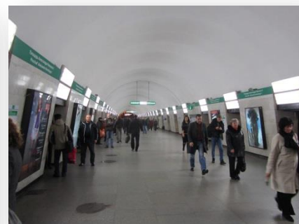
Obrázek 4: Petrohradské stanice odděluje nástupiště od vlakových souprav dveřmi, garantují vyšší bezpečnost cestujících a snižují náklady na architektonické řešení prostoru, jsou však provozně náročnější (viz rovněž Obrázek 22)
