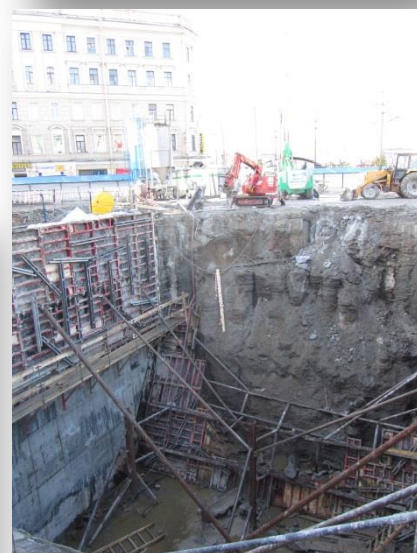
Obrázek 10: Výstavba horního vestibulu stanice metra Admiralteiskaya a jámy pro instalaci razicího štítu pro výstavbu šikmého tunelu nového výstupu ze stanice Sadovaya v Petrohradě (2011)
