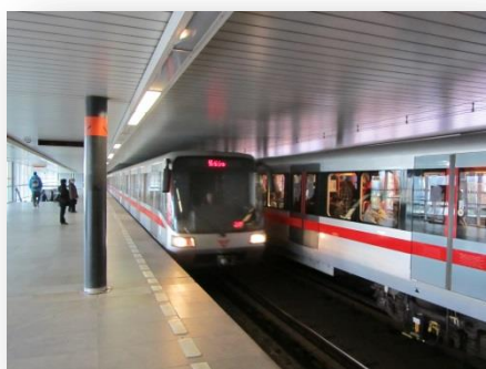
Obrázek 27: Pražská stanice metra Vyšehrad je příkladem stanice s bočními nástupišti, stanice je umístěna na povrchu
