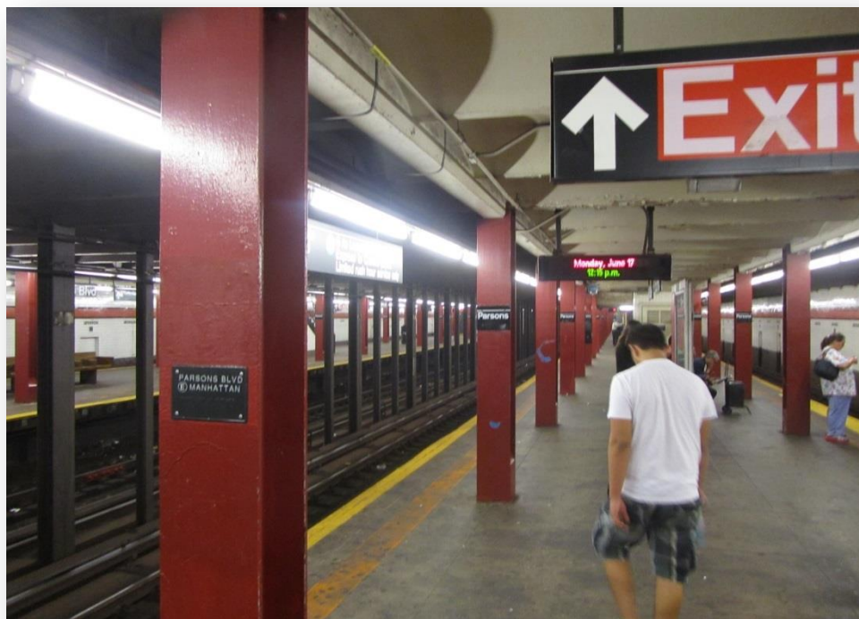
Obrázek 30: Interiér stanic metra v New Yorku svědčí o jeho stáří (stanice v Queensu jsou hloubené, těsně pod povrchem, dvě linky jsou provozovány na společných ostrovních nástupištích)
