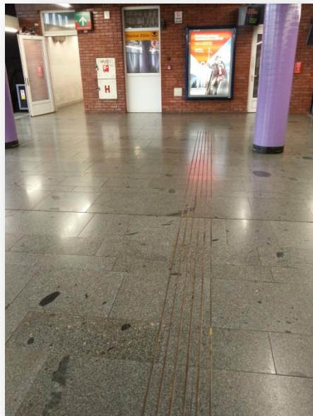
Obrázek 35: Vodící proužky (stanice metra Zličín v Praze)
