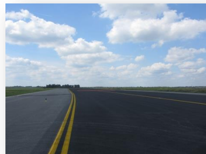
Obrázek 9: Rychlý sjezd dráhového systému letiště v Praze
