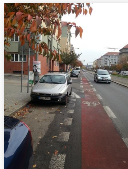
Obrázek 15: Pražská varianta cyklistické stezky (pruhu) na vozovce je investičně méně náročná (pouze vodorovné značení), ale nebezpečnější jak pro cyklisty, tak pro automobilový provoz, odděluje parkující automobily od provozu na vozovce
