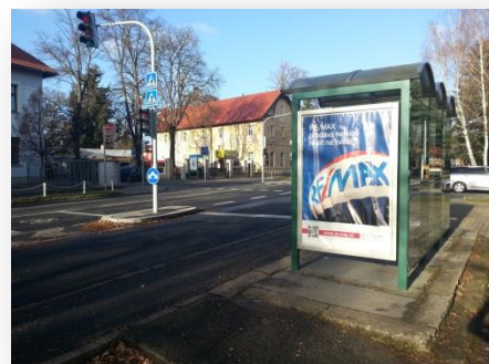
Obrázek 39: Přístřešky zastávek autobusové dopravy (s odděleným pruhem pro přednostní výjezd autobusu na světelně řízené křižovatce)
