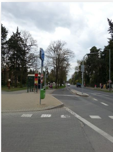
Obrázek 27: Preferenční pruh městské autobusové dopravy spojený se zastávkou (preferenční pruh při výjezdu ze zastávky a vjezdu do křižovatky, řízené SSZ)
