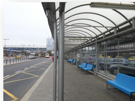
Obrázek 40: Přístřešek skupinové zastávky autobusové dopravy
